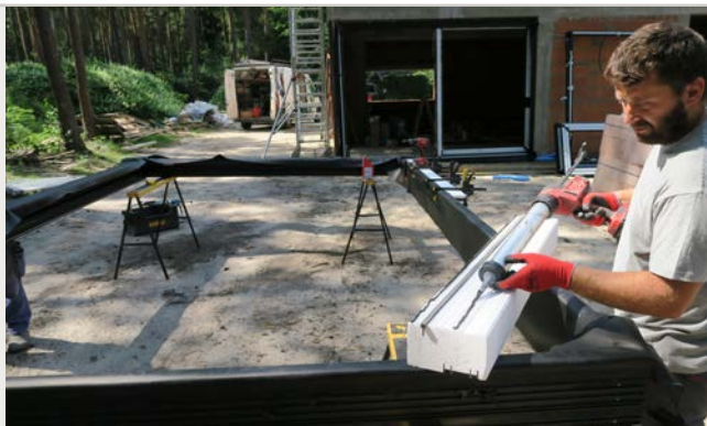
Fot. 6. Izolacja termiczna ramy okna
