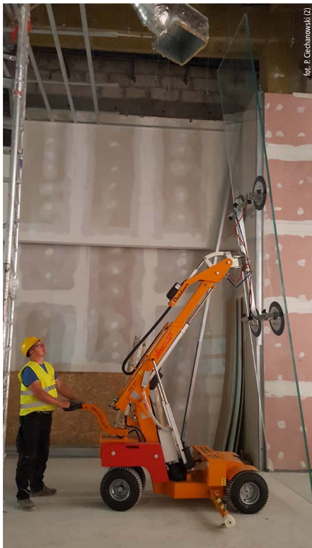
Fot. 12. Transport szyby z użyciem przyssawek i manipulatora
