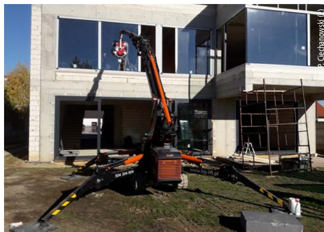
Fot. 16. Montaż szyby na wyższej kondygnacji
