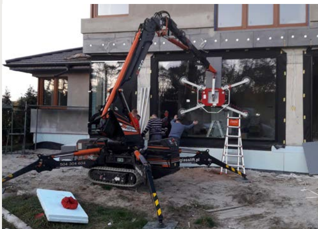
Fot. Montaż okna typu Fix
