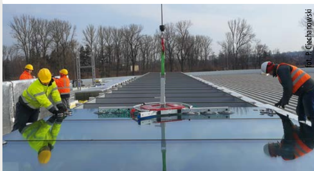
Fot. 4. Montaż świetlika dachowego
