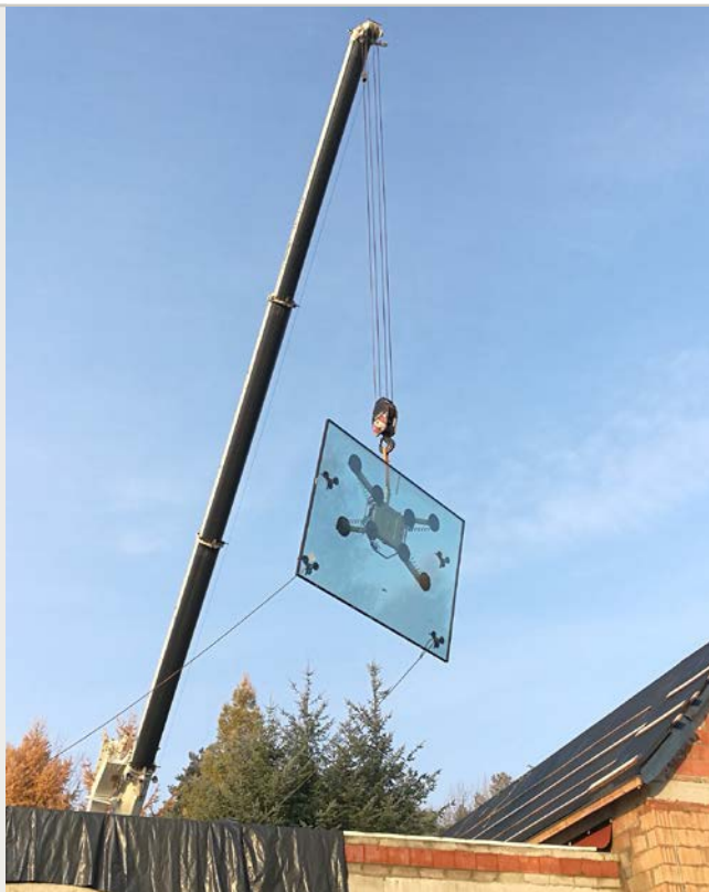
Fot. 13. Przenoszenie szyby przy pomocy żurawia
