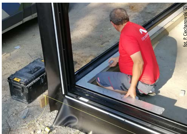
Fot. 9. Kontrola zachowania zaprojektowanego kąta podczas montaż okna narożnego
