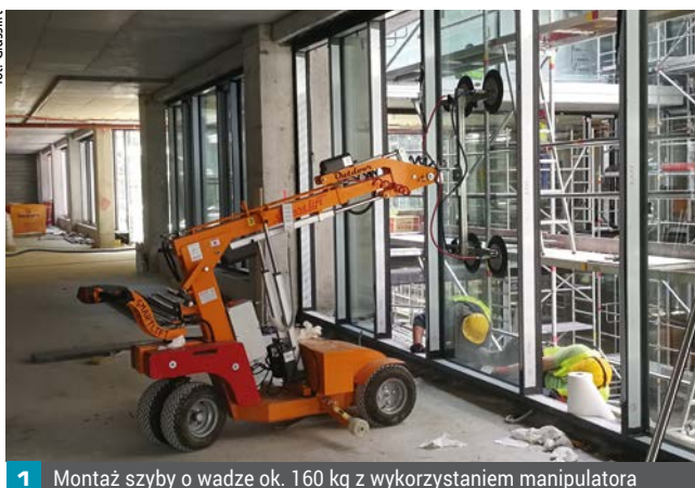
1 Montaż szyby o wadze ok. 160 kg z wykorzystaniem manipulatora
