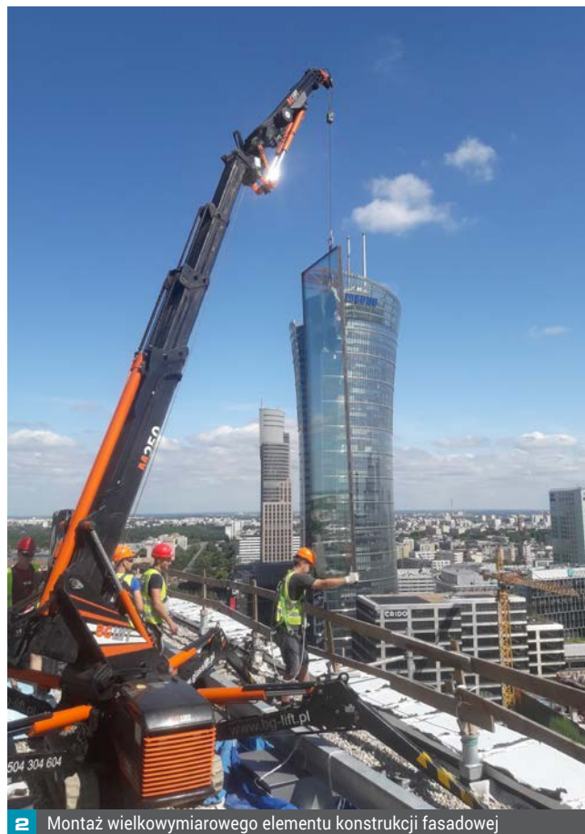
2 Montaż wielkogabarytowego elementu konstrukcji fasadowej
